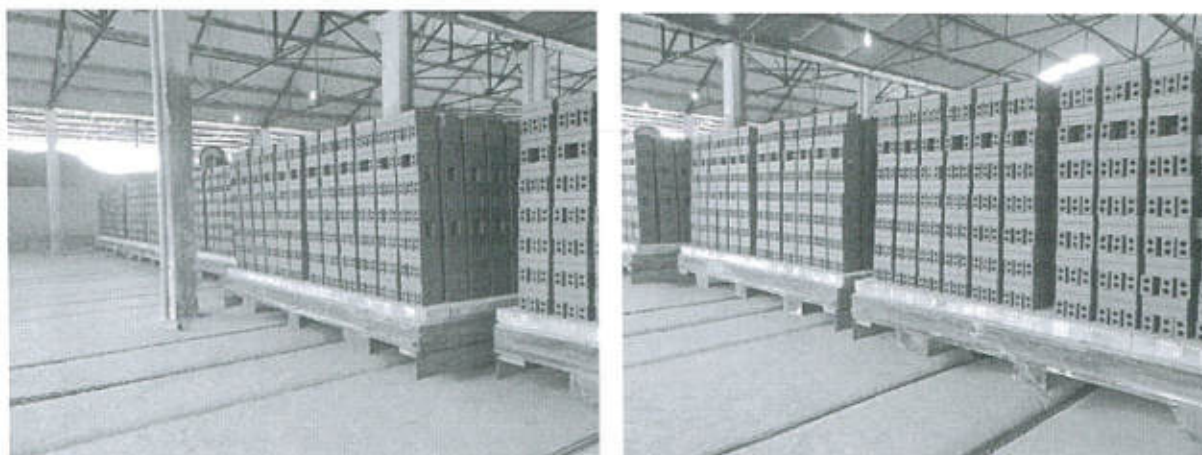
Hình 4. Một số hình ảnh nhà máy gạch của Công ty
